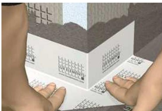
**DRY-DBAE** применяется для гидроизоляции внешних углов. Переходы в области стен и потолков можно герметизировать особыми уплотняющими лентами и фасонными деталями, что существенно облегчает работу мастера.
