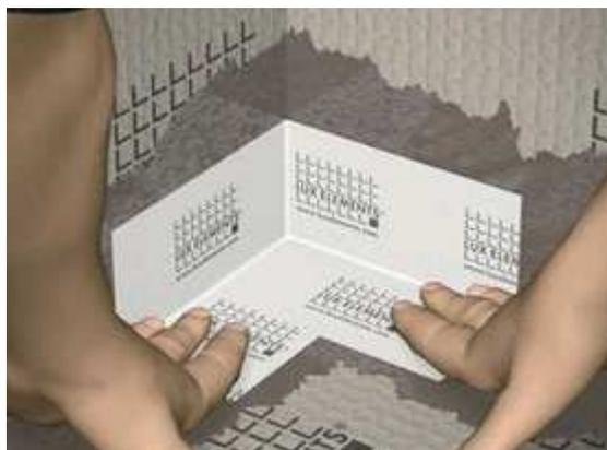
**DRY-DBIE** применяется для гидроизоляции внутренних углов. Переходы в области стен и потолков можно герметизировать особыми уплотняющими лентами и фасонными деталями, что существенно облегчает работу мастера.
